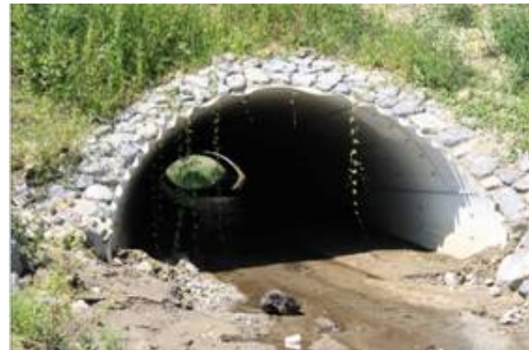
Neubau der B30 mit Schussen-Renaturierung (August 2009): Durchlass eines zufließenden Bachs
